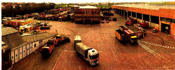
Panoramica impianto Bra Servizi
